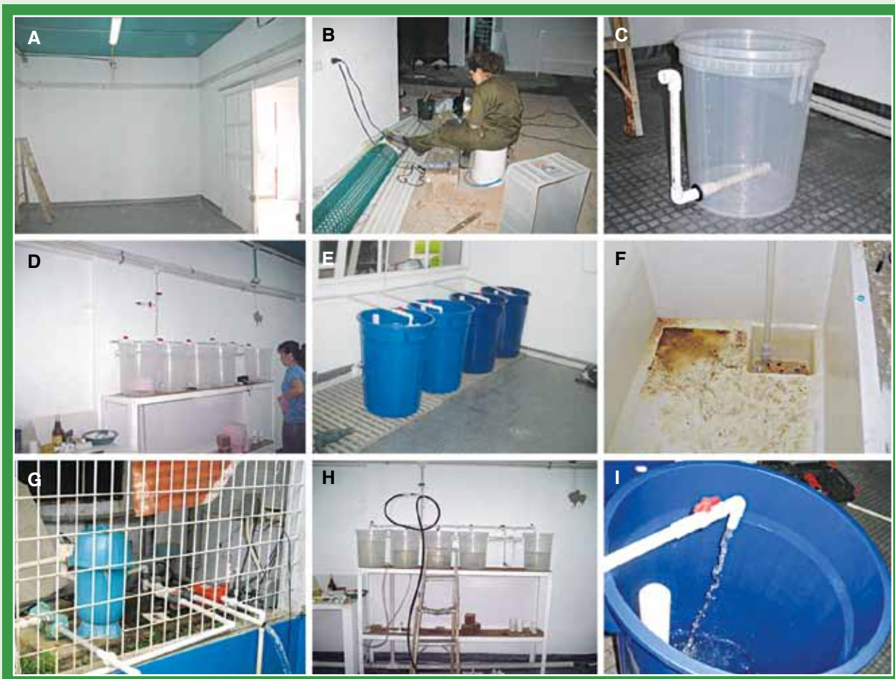
Figura 24. Adecuación y montaje de los sistemas de producción de caballito de mar en las instalaciones de langostino del Llano LTDA. (A y B), incubadoras de 20L para levante de crías (C y D), tanques de 110L para reproductores (E), reservorio (F), sistema de bombeo (G) y sistemas en funcionamiento (H e I).
