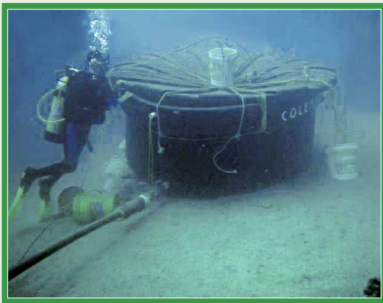
Figura 11. Filtro sumergido de la toma de agua del LABBIP.
