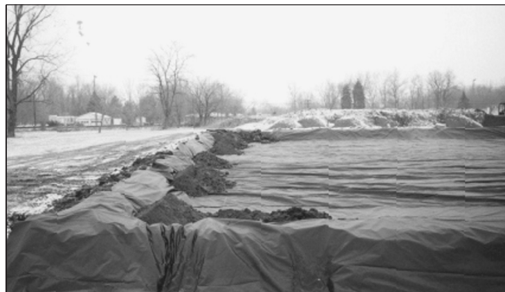
Figura 8. Adecuación de terreno para el esparcimiento de suelo contaminado. Fuente: Environmental field services Inc. 2004
