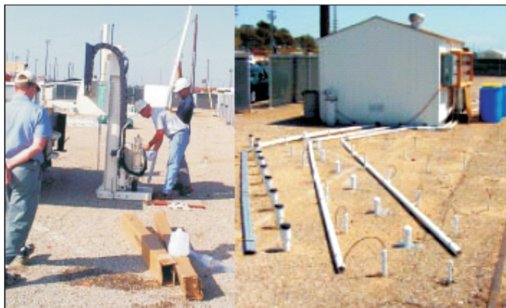
Figura 5. Inyector de aire y nutrientes para el tratamiento de suelo contaminado con MTBE (metil-ter-butil-eter). Fuente: Azadpour-Keeley, A. 2002.
