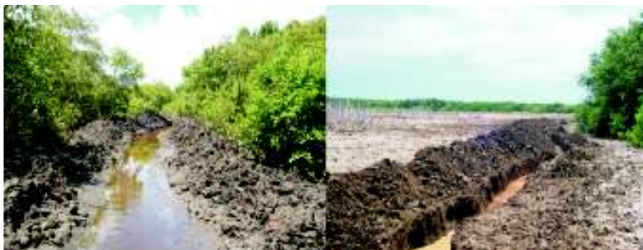
Figura 5-3. a) Aspecto de apertura o rehabilitación de caños y canales en áreas de manglar. b). Apertura o rehabilitación de caños y canales en áreas de manglar sobre playón deteriorado
