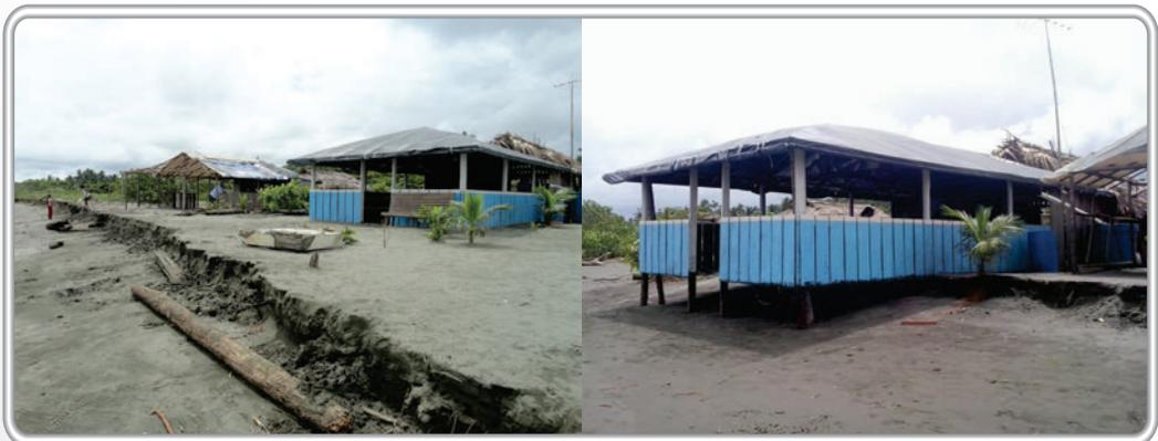
**Figura 10.** Retroceso costero y cambios volumétricos en el corregimiento de La Barra, Pacífico Colombiano. Fotografía izquierda tomada el 25 de mayo de 2013, fotografía de la derecha tomada el 24 de julio de 2013 (Programa GEO, Invemar).
