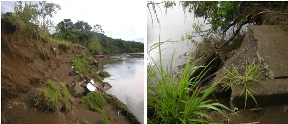
**Figura 2.5.** Erosión del talud de la superficie donde se encuentra localizado el cementerio (izquierda). Remanente de un acceso de cemento que conducía al cementerio que colapsó debido a la socavación por parte del río (derecha).
