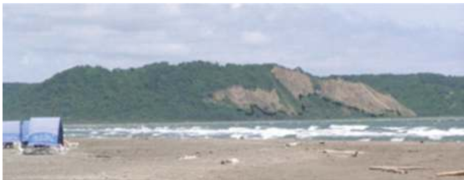
Figura 15. Deslizamiento planar con cono de deslizamiento en su base. Localizado al suroeste del poblado de Arroyo de Piedra (Julio de 2010).
