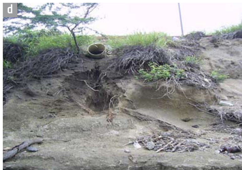
Figura 6.17. a) Erosión de la playa de Pozos Colorados por oleaje alto con evidencias de destrucción de estructuras, cercas y vegetación; b) Acantilados del aeropuerto afectados por escorrentía y socavación de la base; c) Taludes en el sector del aeropuerto con retroceso rápido por desprendimiento de masas de suelo; d) Talud inferior de la vía al aeropuerto con problemas erosivos por drenajes, escorrentía y socavación por el oleaje (fotos Programa GEO-INVEVAR).
