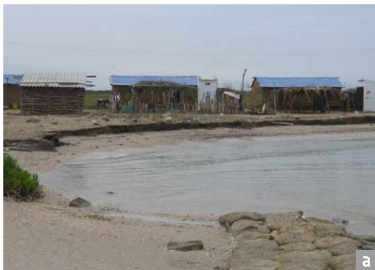
Figura 6.49. a y b) Erosión intensa en las playas del sector de Pájaro, con escarpes de erosión pronunciados, viviendas destruidas, bolsacretos y espolones en mal estado (fotos de la comunidad).
