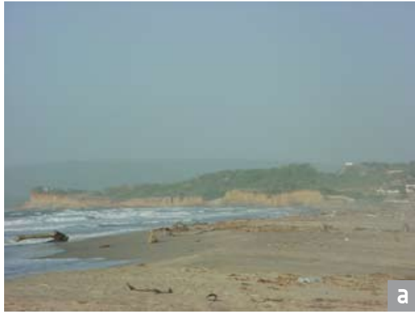
Figura 6.22. a y b) Erosión en los acantilados entre punta Sabanilla y el cerro Furú por efectos del oleaje y la escorrentía; c) Escarpes de playa y protección con muros; al fondo, erosión de acantilados (fotos Programa GEZ-INVEMAR).
