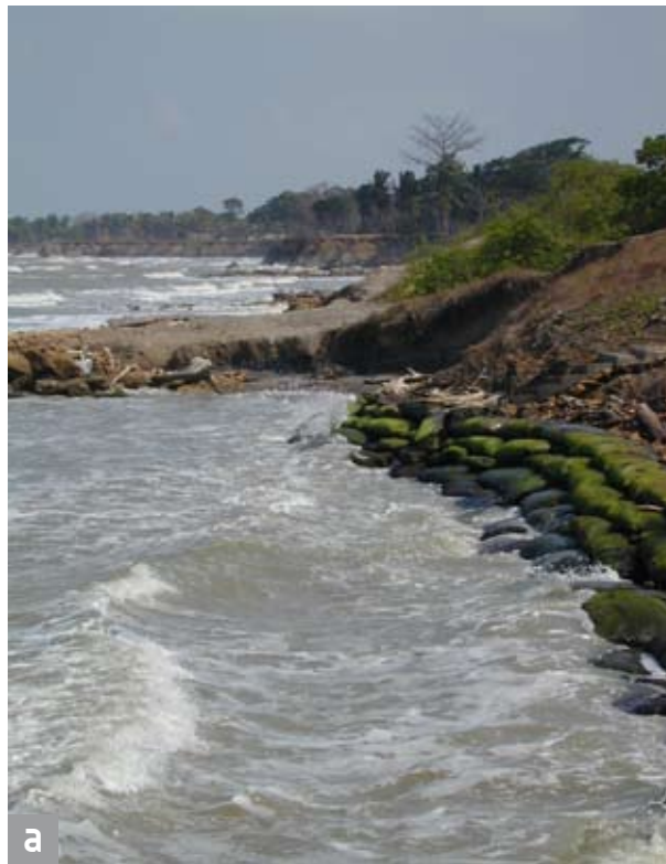
Figura 6.45. a) Ladera inferior del volcán de lodo de Arboletes afectada por la erosión marina y muestra de mitigación de dicha acción erosiva mediante la colocación de bolsacretos; b y c) Acantilados altamente erosionados en el corregimiento de Zapata, municipio de Necoclí; d) Erosión costera en el casco urbano de Necoclí que destaca lutitas meteorizadas y muy fracturadas (fotos Programa GEO-INVEMAR).
